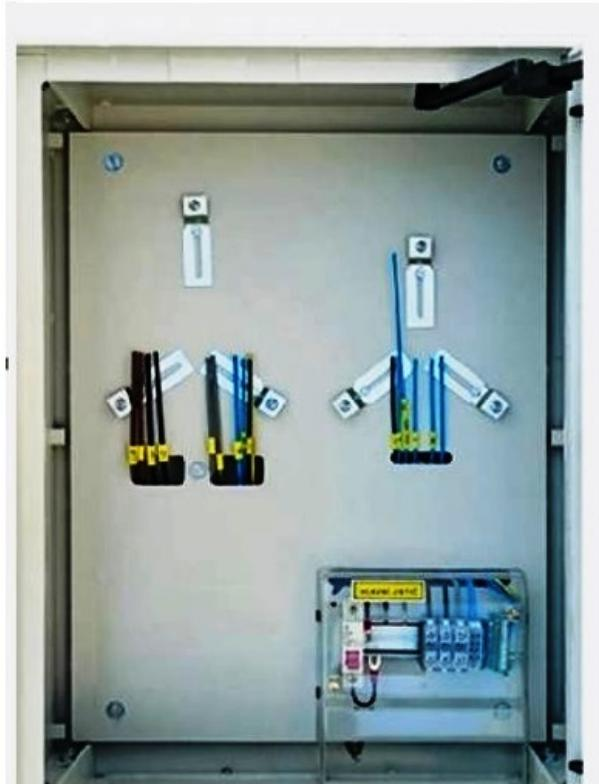
Obr. 3 Elektromerové rozvádzace sú pripravené na osadenie elektromera a hlavného ističa
