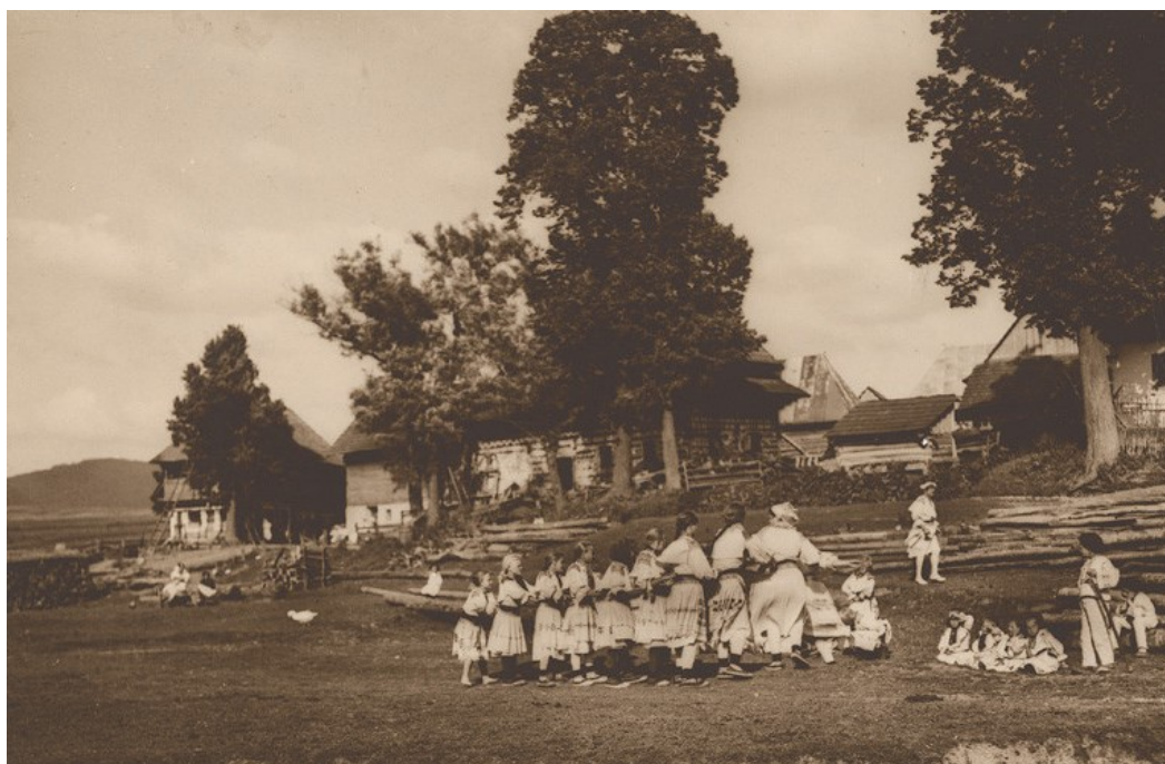
02 Čičmany. Joklov dom (Bachňa) a dom Staré Gocmanovce 1929
